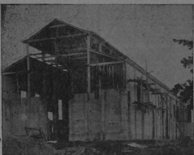
Estado en que se encuentran los trabajos de edificación de la Iglesia de San Nicolás, en Cartago.
